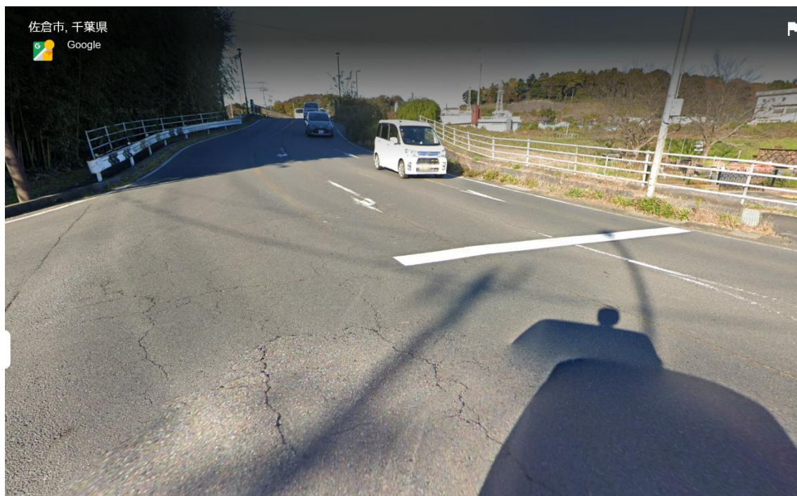
【図1】鹿島橋たもと付近の路面(Google ストリートビュー2024 年 11 月撮影)。車線境界線(黄色)や、進行方向指示標示が消えかかっている。
